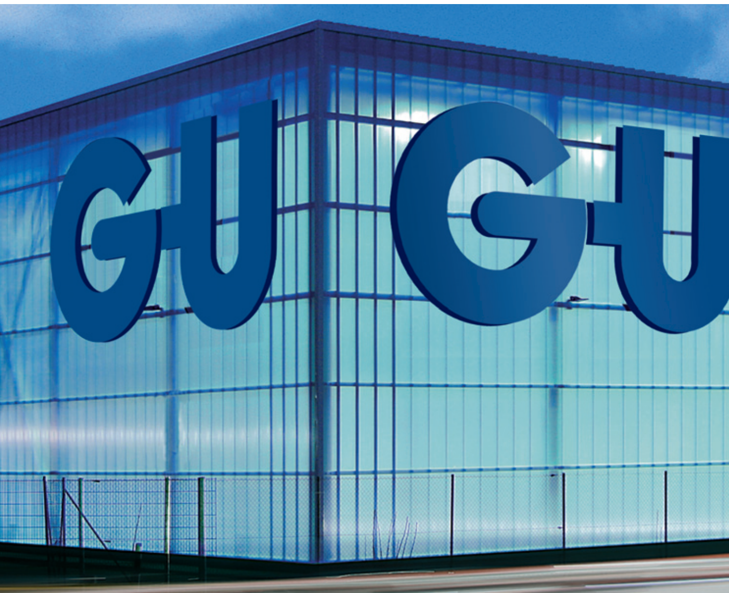
Mit freundlicher Genehmigung von kab planungsbüro für bauleistungen gmbh, Fellbach
